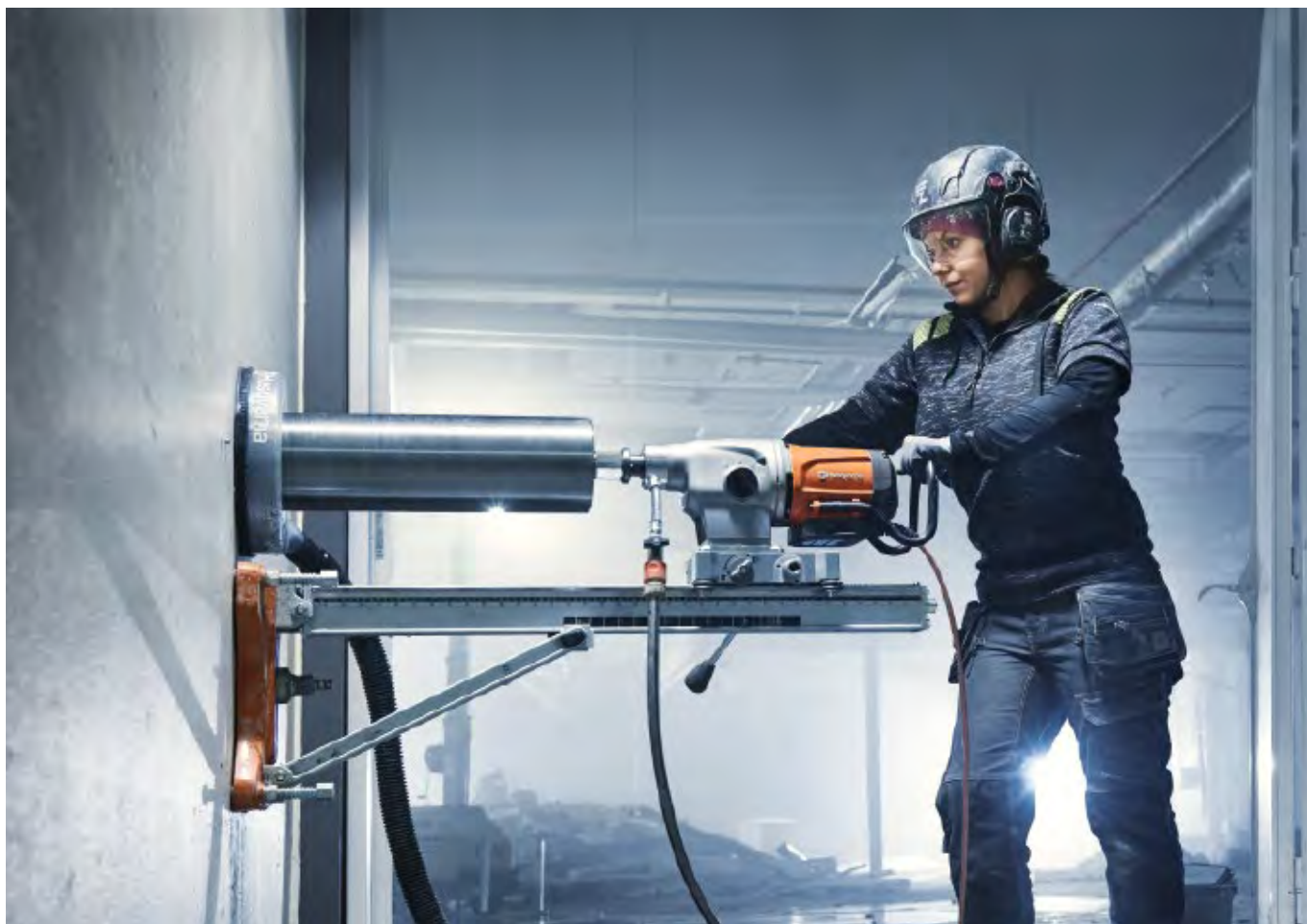
14 Automatisches Bohrsystem AD 10
